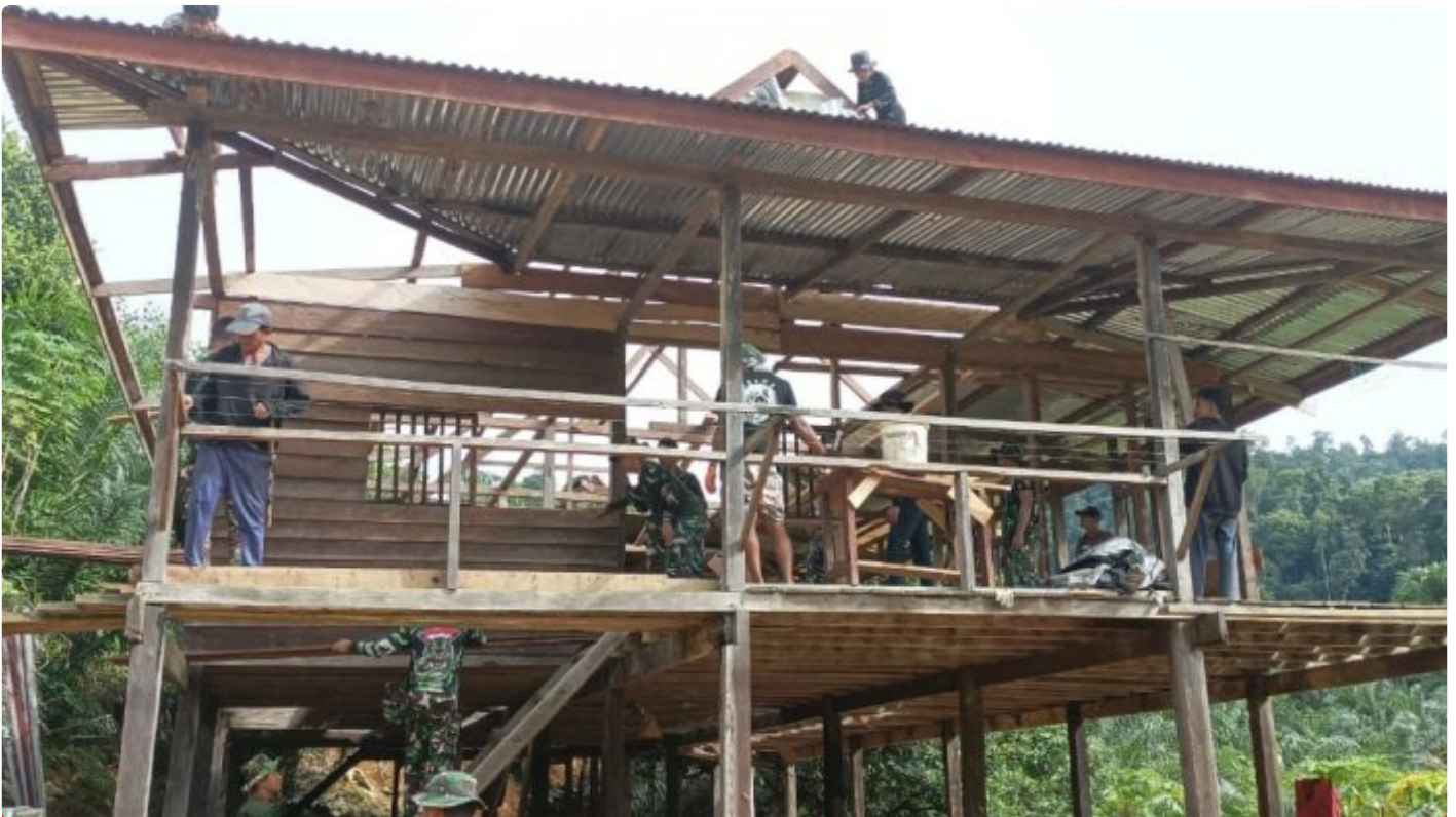
Foto Pembongkaran Rumah Warga
